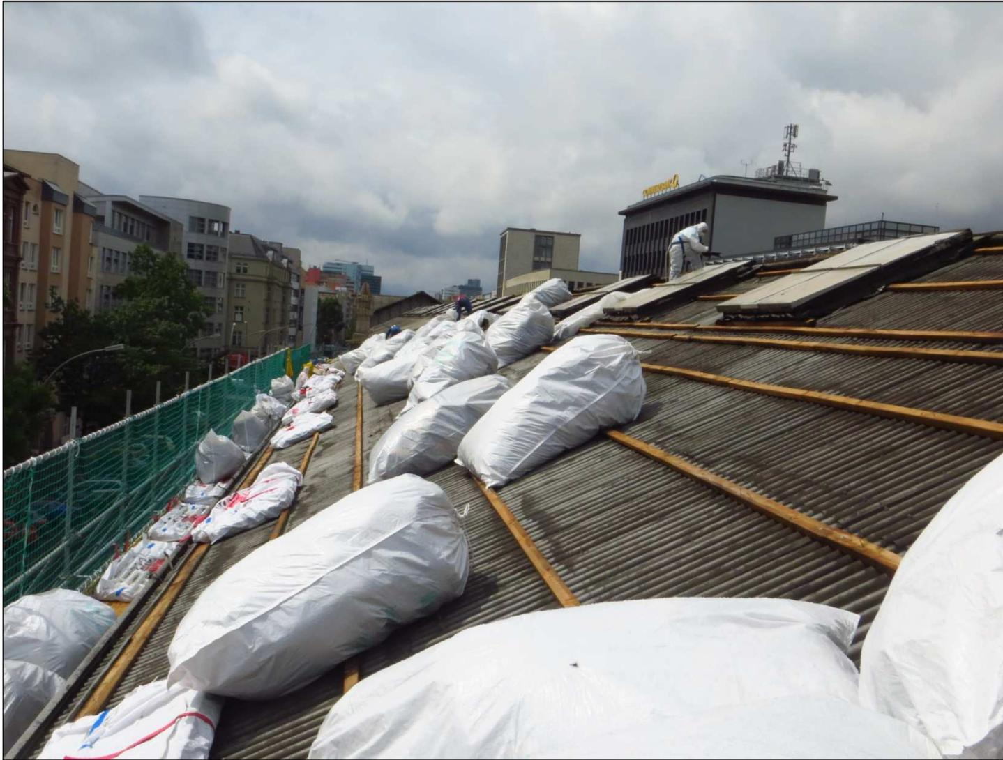
Rückbau der asbesthaltigen Wellplatten
