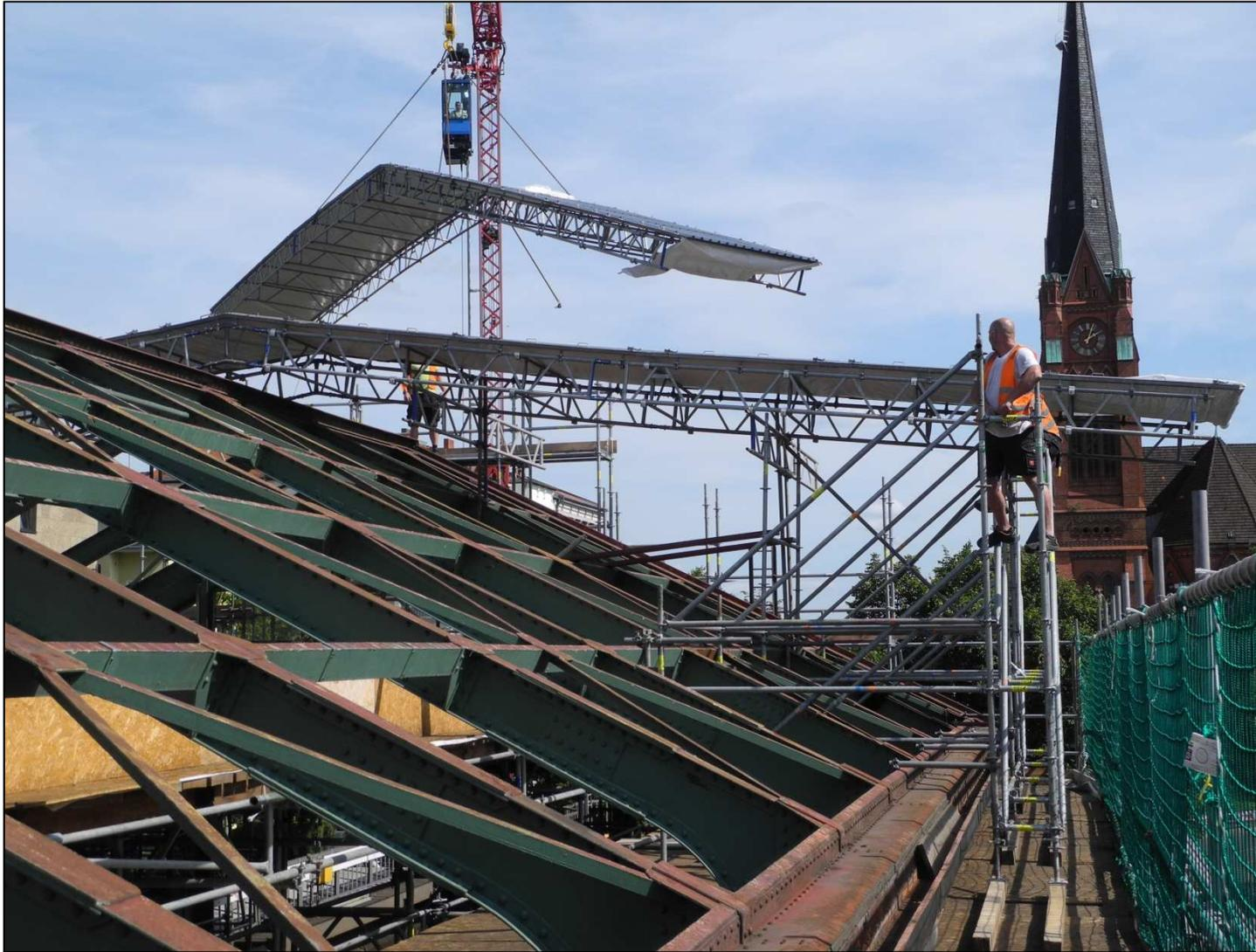
Aufbau Dacheinhausung für das Sandstrahlen
