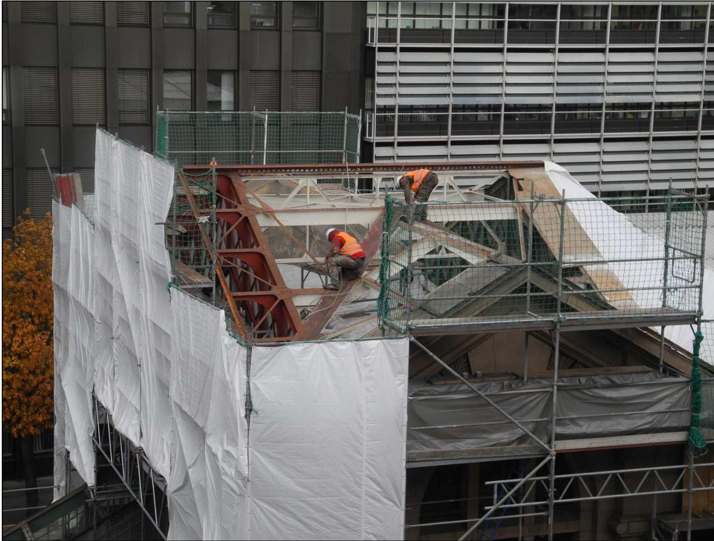
Handentrostung der Dachkonstruktion des Vorhauses
