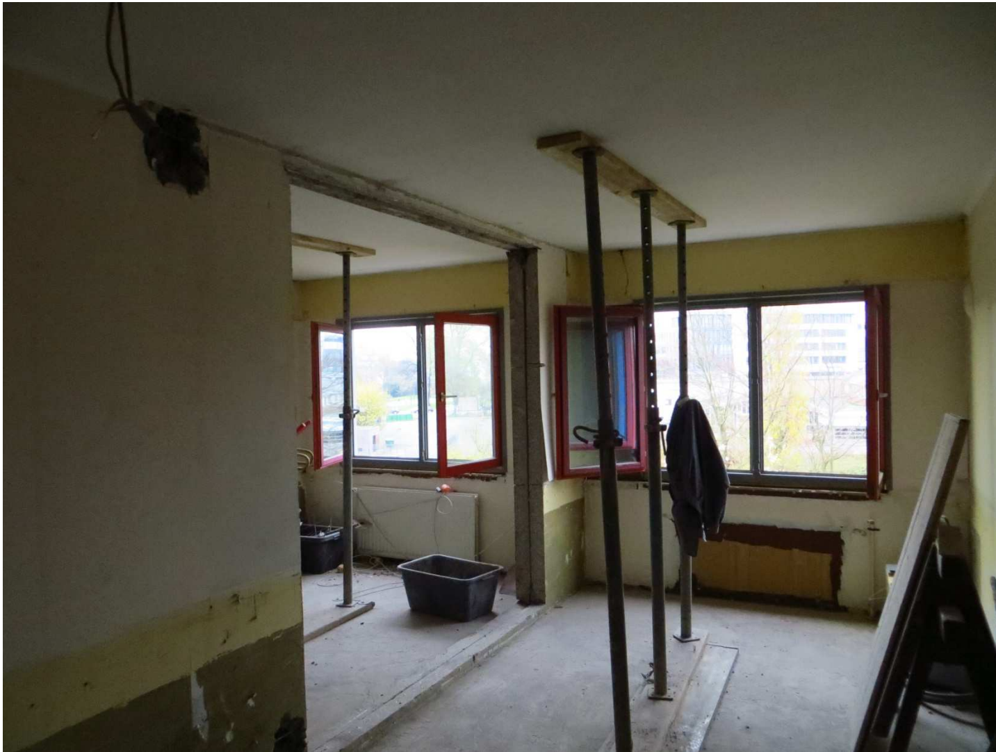
Zusammenlegung von zwei Zimmern
