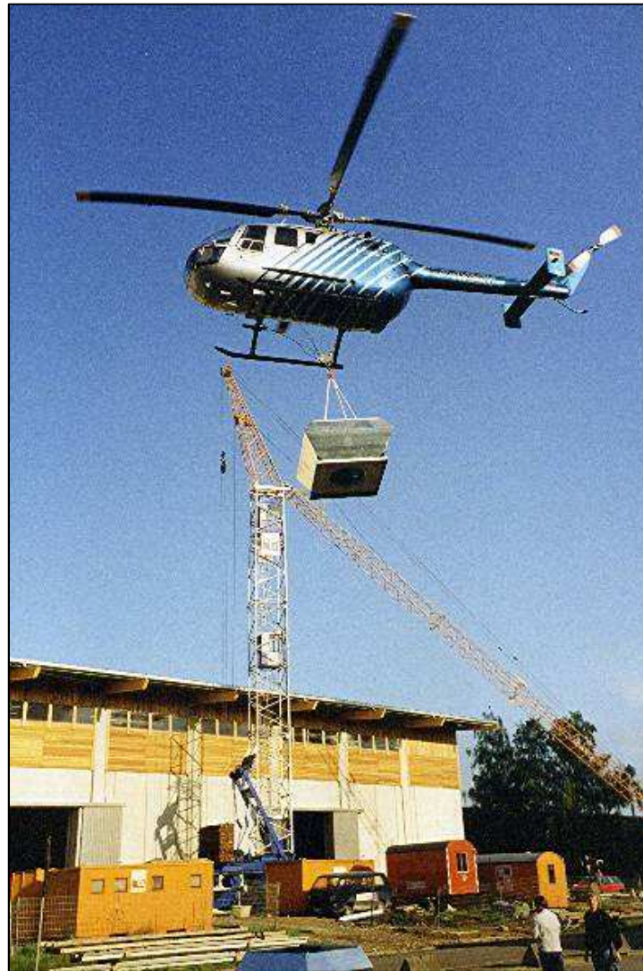
Lüftermontage mit Helicopter
