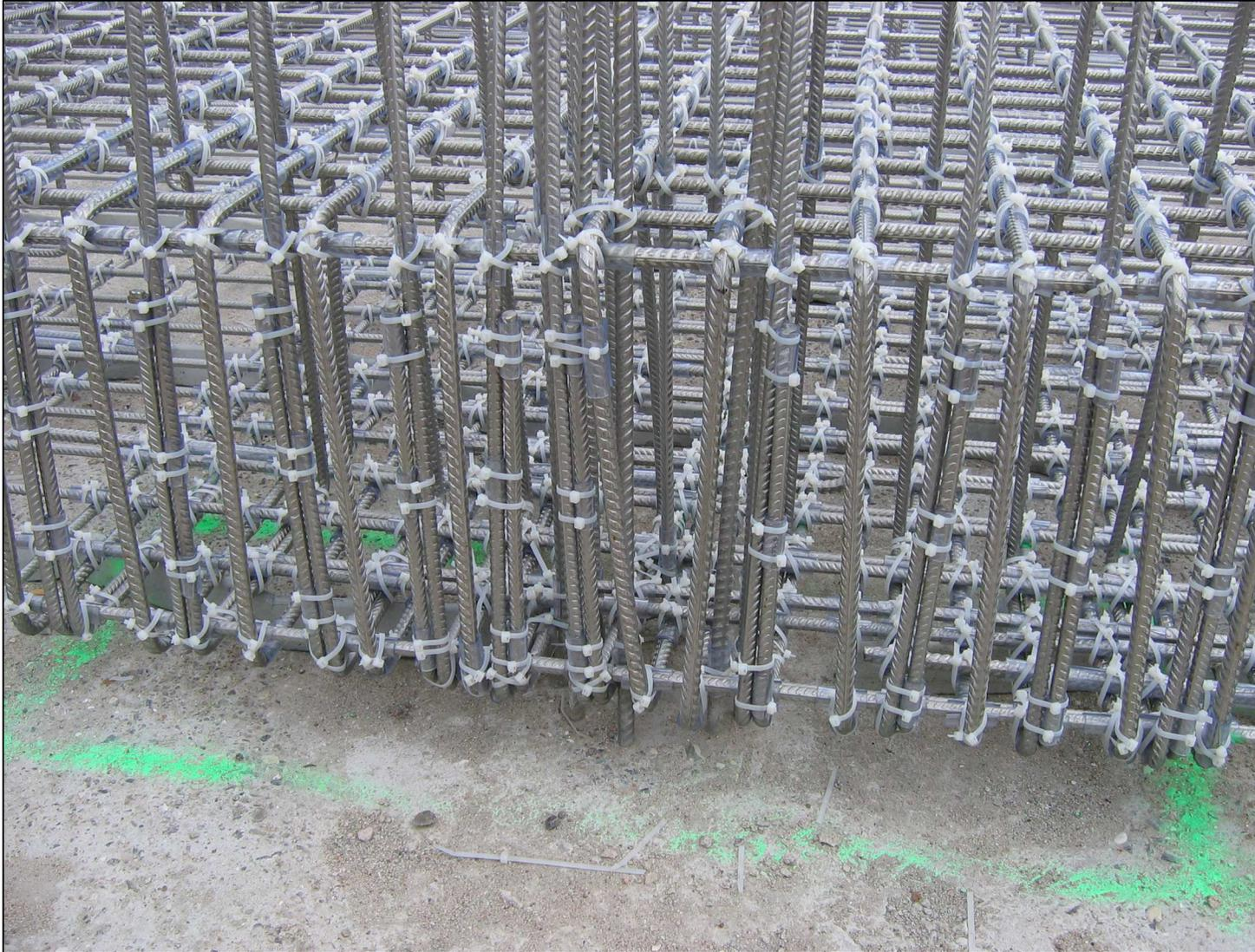
Bewehrung der Bodenplatte für das Spulengebäude einschl. der Bohrpfahlbewehrung aus Edelstahl; Kontaktstellen gegeneinander isoliert
